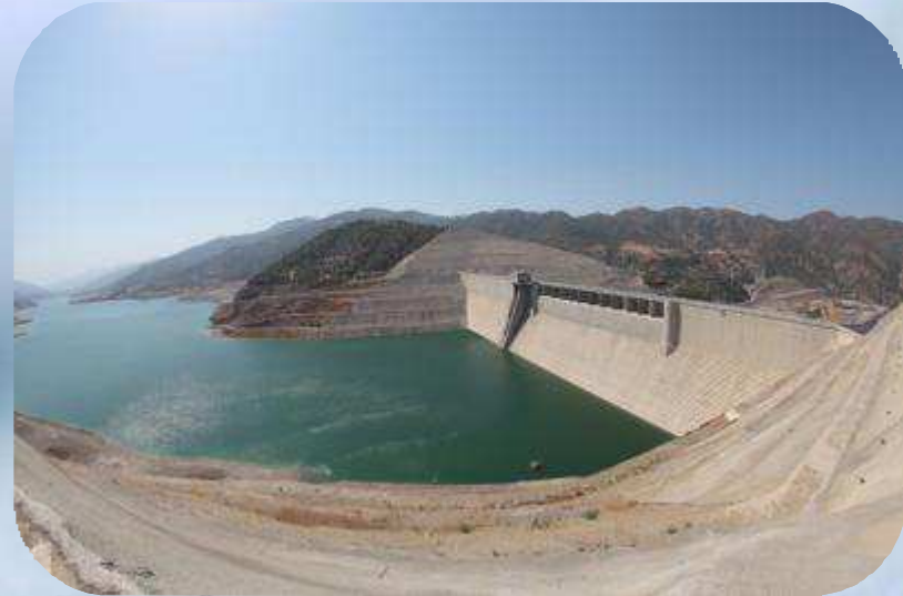
Barrage de Koudiat Acerdoune Capacité: 640 Hm 3
